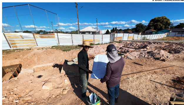
Obra da nova escola, que funcionará em tempo integral
