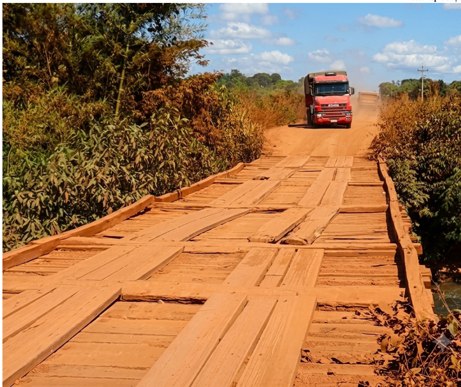
Ponte de madeira está com a estrutura comprometida e oferece risco aos motoristas
